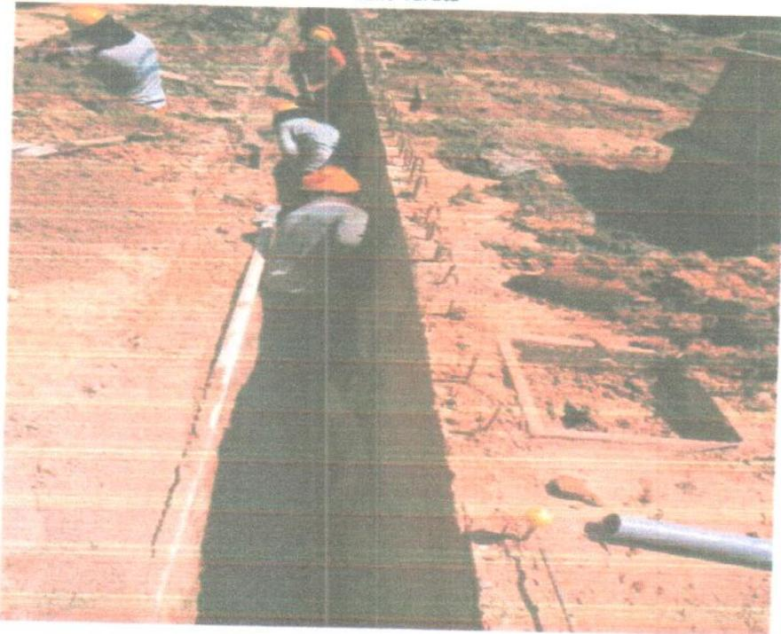
Fotografía N°04. Se aprecia la excavación para el tendido de tubería PVC SAP para el sistema de agua potable, ubicado en la calle marañón
