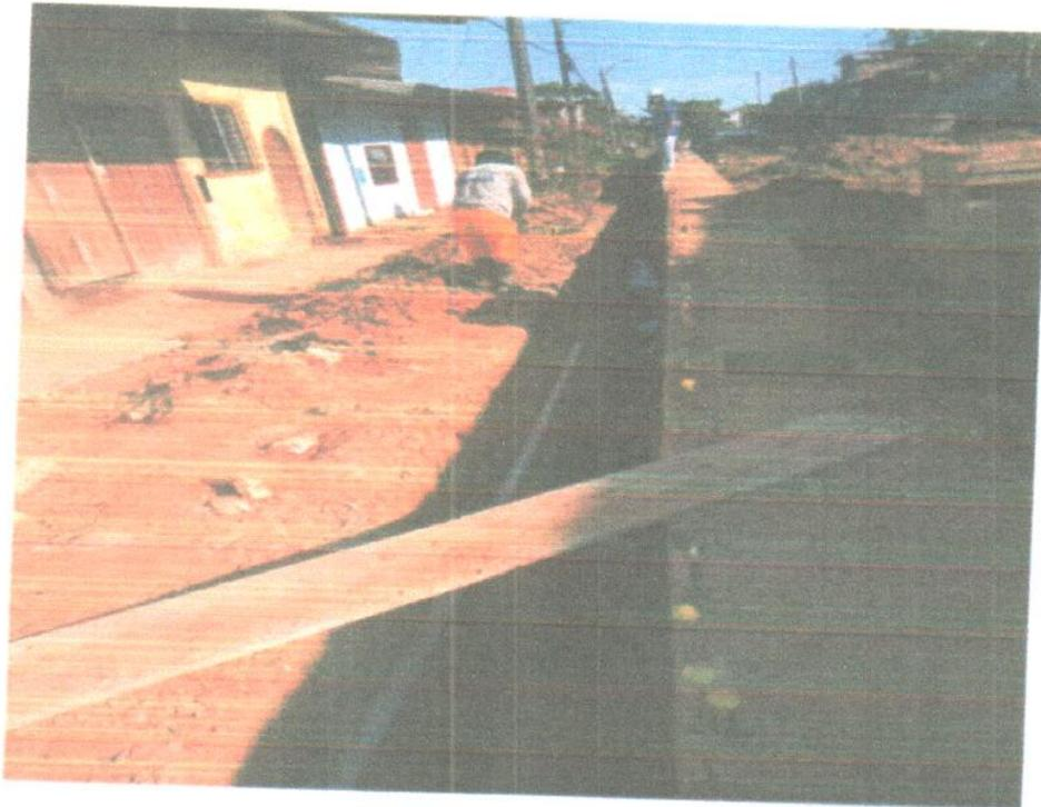
Fotografía N°02. Se aprecia el tendido de tubería PVS SAP, para el sistema de agua, en la calle condamine cuadra 03
