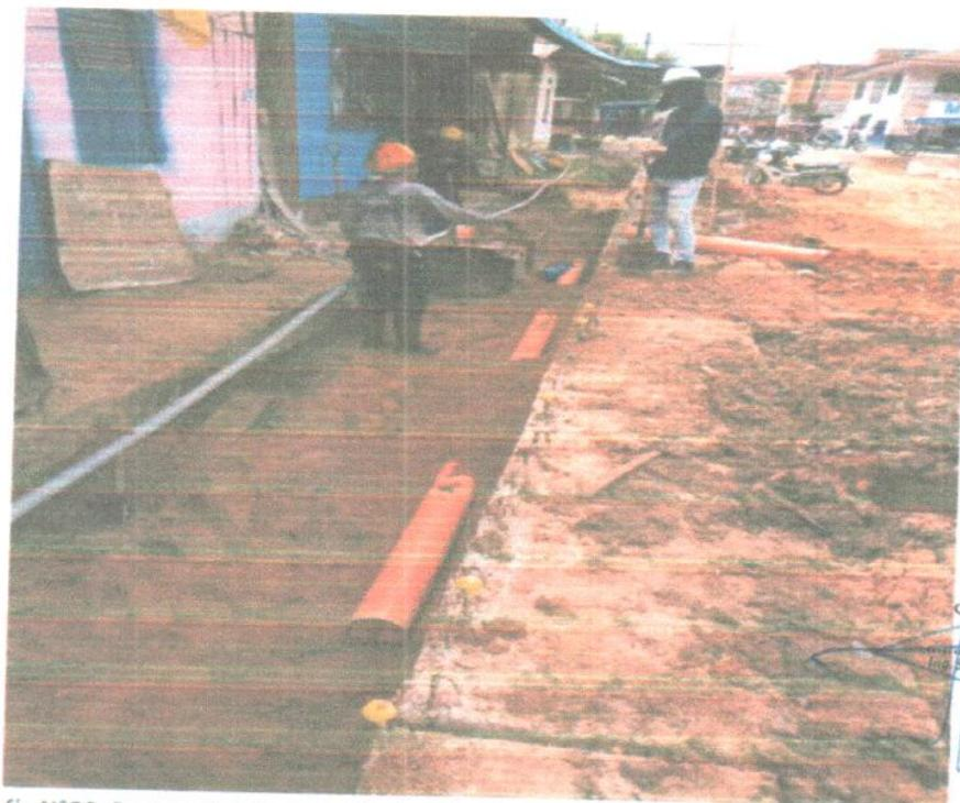
Fotografía N°06. Se aprecia la instalación de tubería PVC SEL, para el sistema de desagüe en la calle condamine cuadra 03.
