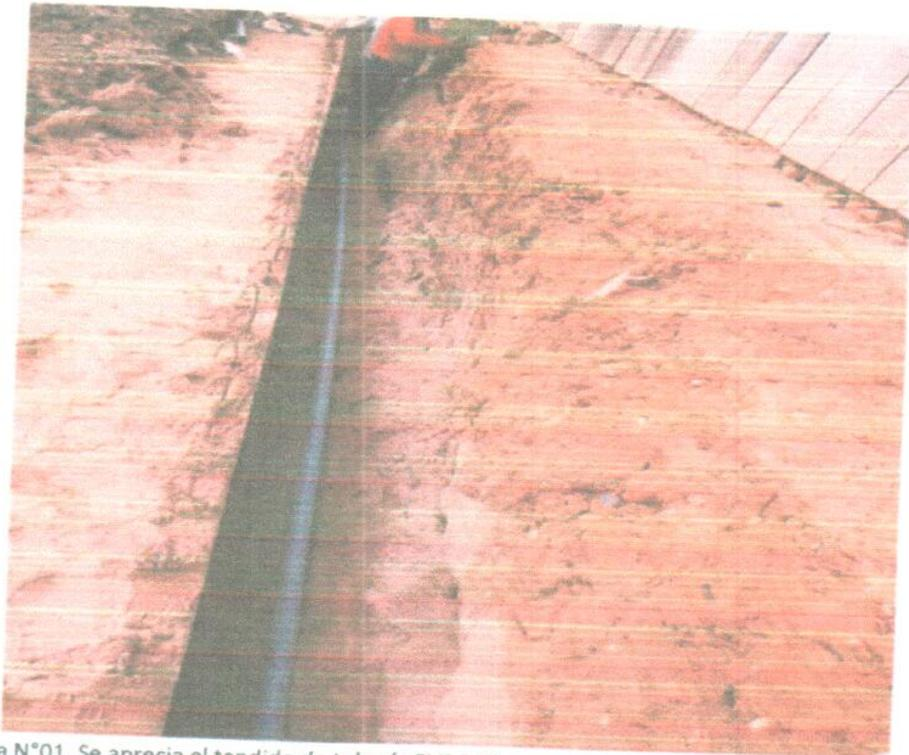
Fotografía N°01. Se aprecia el tendido de tubería PVS SAP, para el sistema de agua, en la calle Raymondi.
