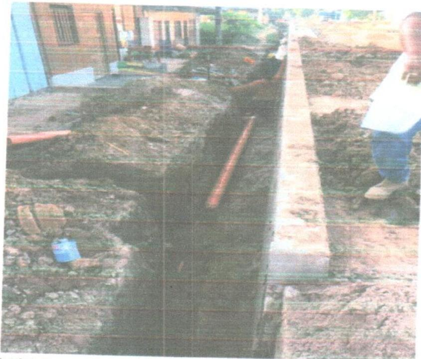
Fotografía N°05. Se aprecia la instalación de tubería PVC SEL, para el sistema de desagüe en la calle raymondi.
